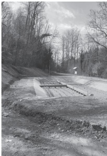
Qualche settimana fa sono stati completati i lavori di realizzazione della fitodepurazione delle acque reflue provenienti dallo scolmatore della fognatura di Cascina Incasate.
