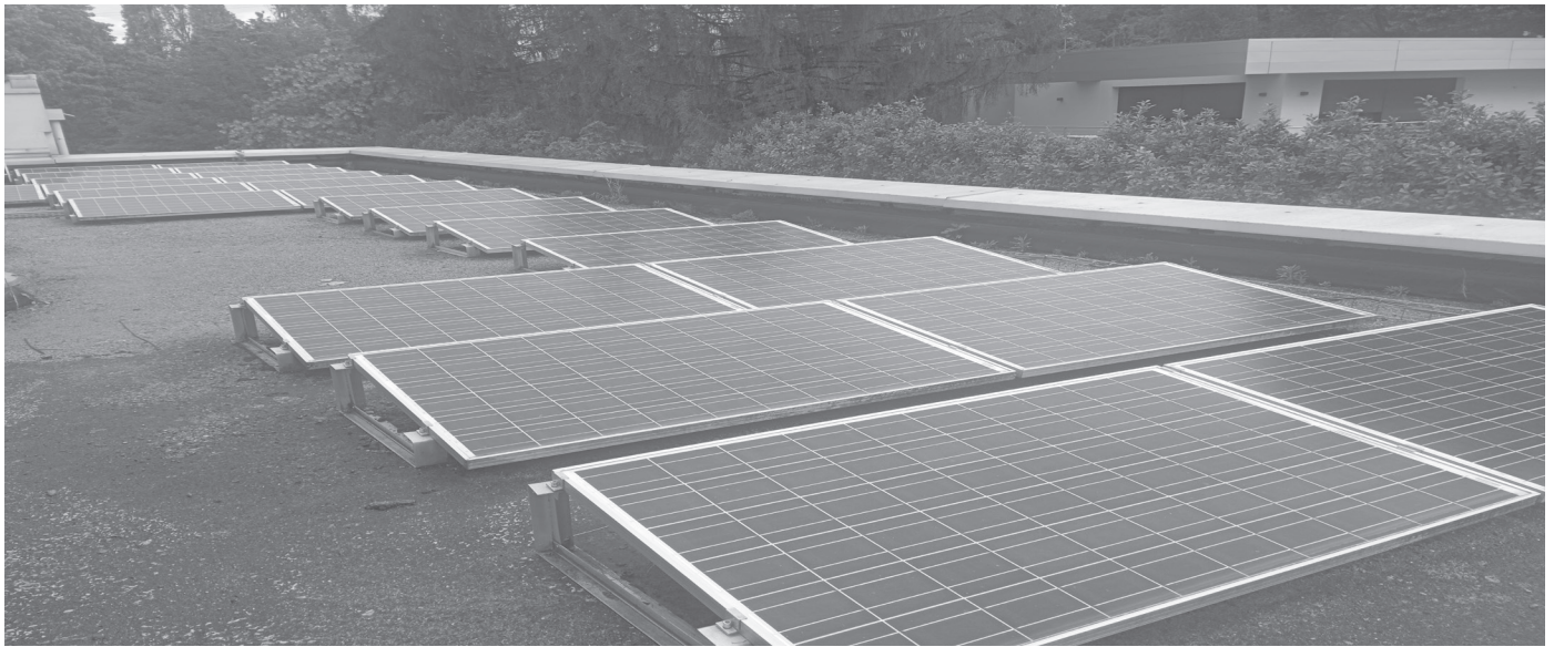
In corso i lavori di installazione delle batterie accumulatrici dell'energia prodotta
